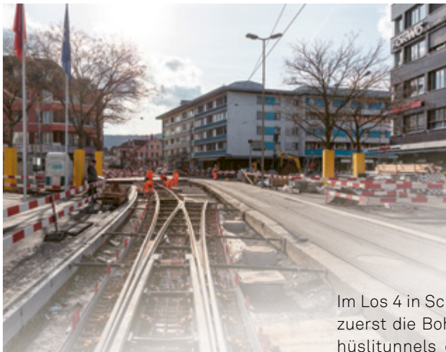
Trasseebaustelle im Zentrum Dietikon
