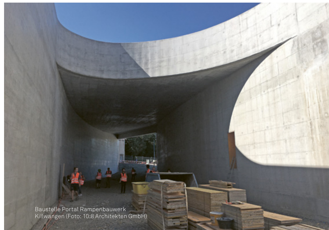
Baustelle Rampenbauwerk Killwangen
