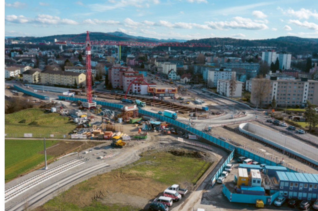
Bau des Bunkerknotts in Dietikon
