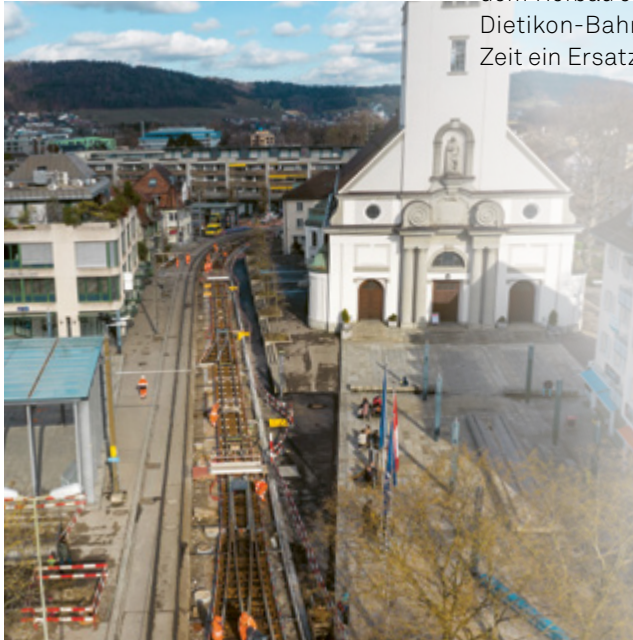
Baustelle beim Kirchplatz in Dietikon
