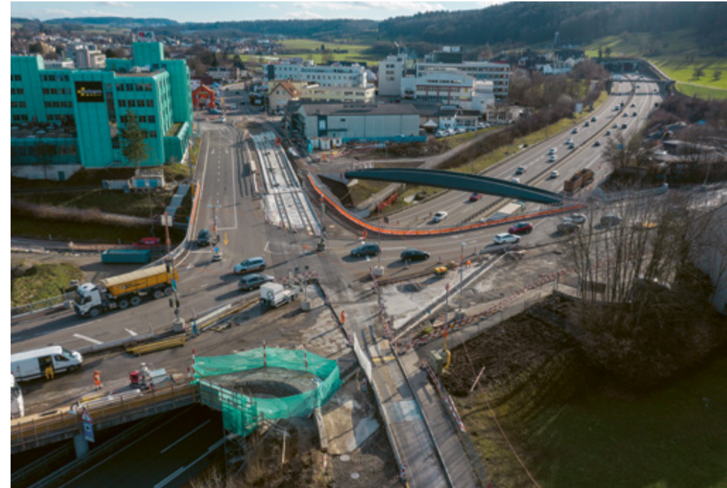
Ausbau der Brücke Herweg über die Autobahn bei Urdorf
