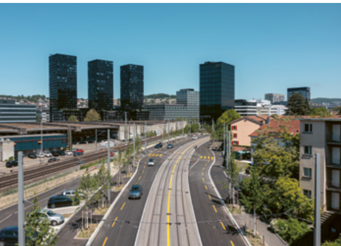
Trassee mit Spezialasphalt in der Hohlstrasse Zürich
