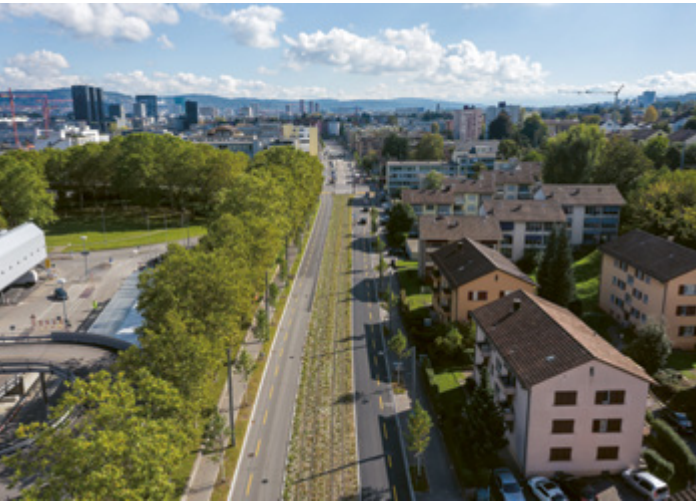
Grüntrasse Zürcher-/Badenerstrasse auf Höhe Post Mülligen, Blickrichtung Stadt Zürich
